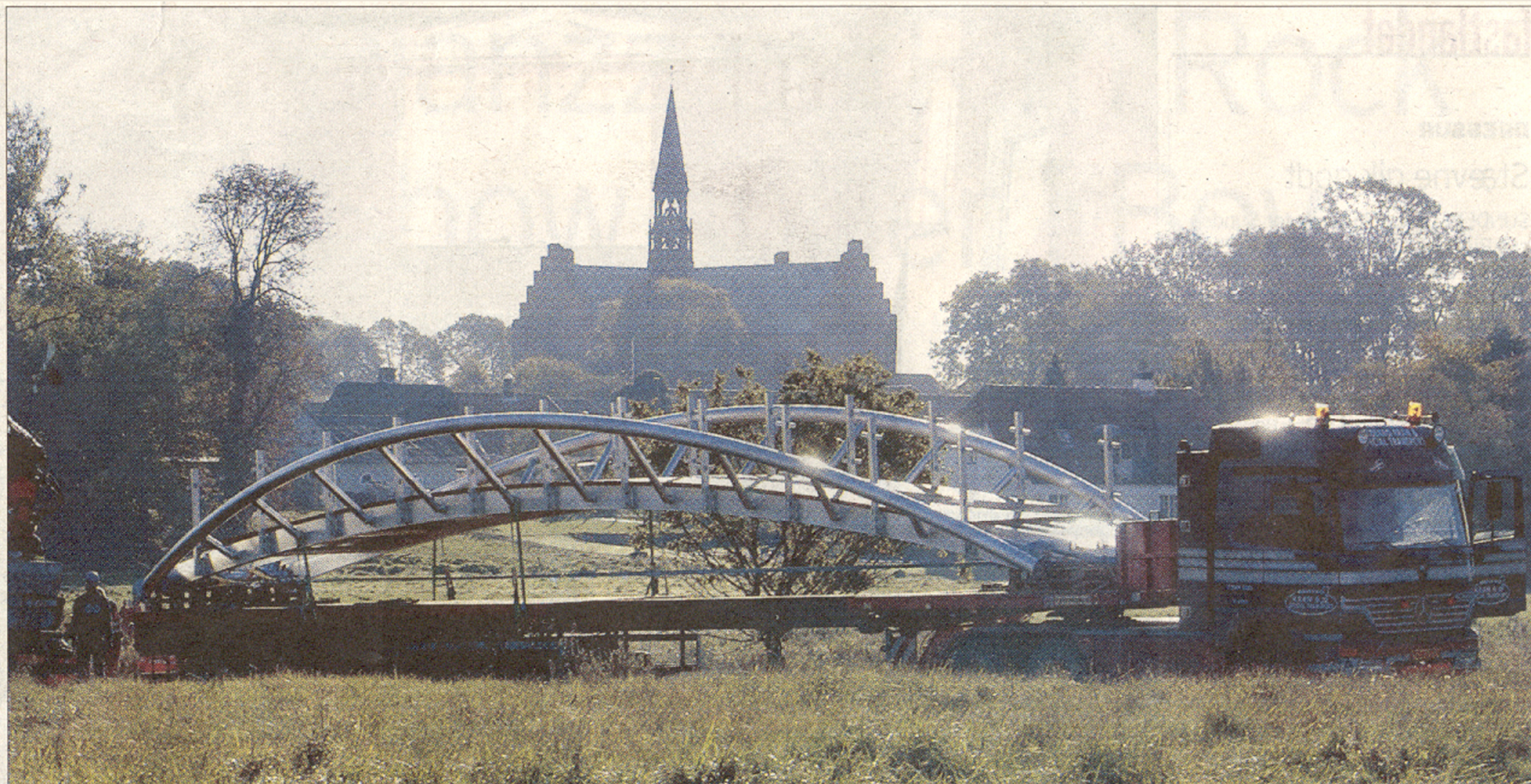
Løgumkloster har fået endnu et vartegn: en bro i aluminium. Broen er 17 meter lang, vejer fire ton og er beklædt med træsorten azorbè, der også er den træsort, som Vidåslusens porte er fremstillet af.
